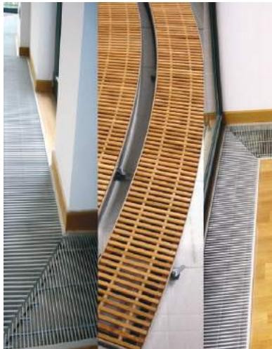
Convectorii noștri facuți după nevoile clientului pot copia diferite forme ale camerei: RCNa/RCFa (arc) și RCNz/RCFz (zig-zag). Cu un schimbător de căldură curbat și un cadru de aluminiu personalizat, RADOX poate produce convectori de pardoseală făcuți la comandă pentru orice stil arhitectural, cu o calitate excepțională și foarte eficiente energetic.
